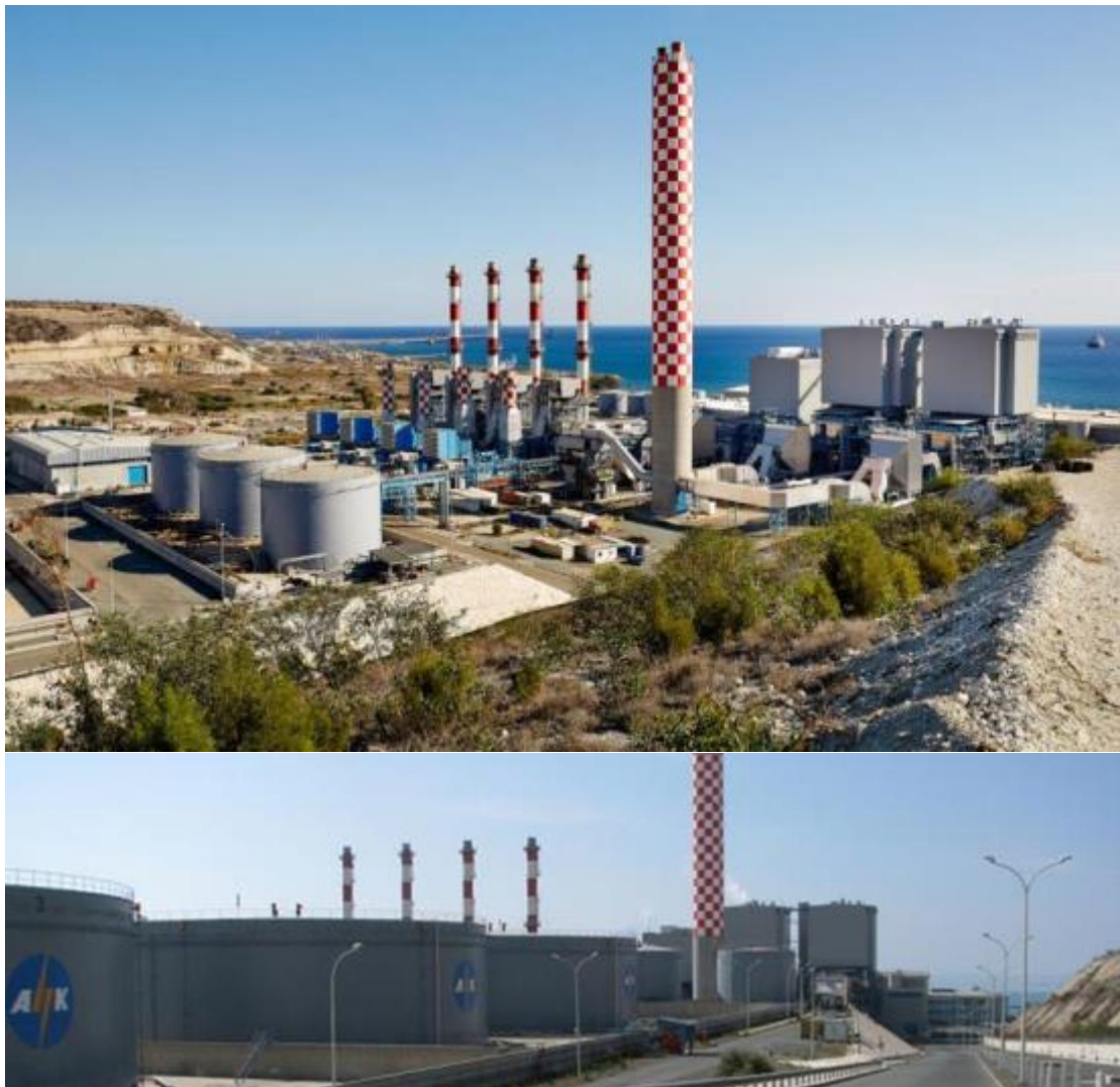
Εικόνα 4-1. Ηλεκτροπαραγωγός Σταθμός (ΑΗΚ) Βασιλικού.
