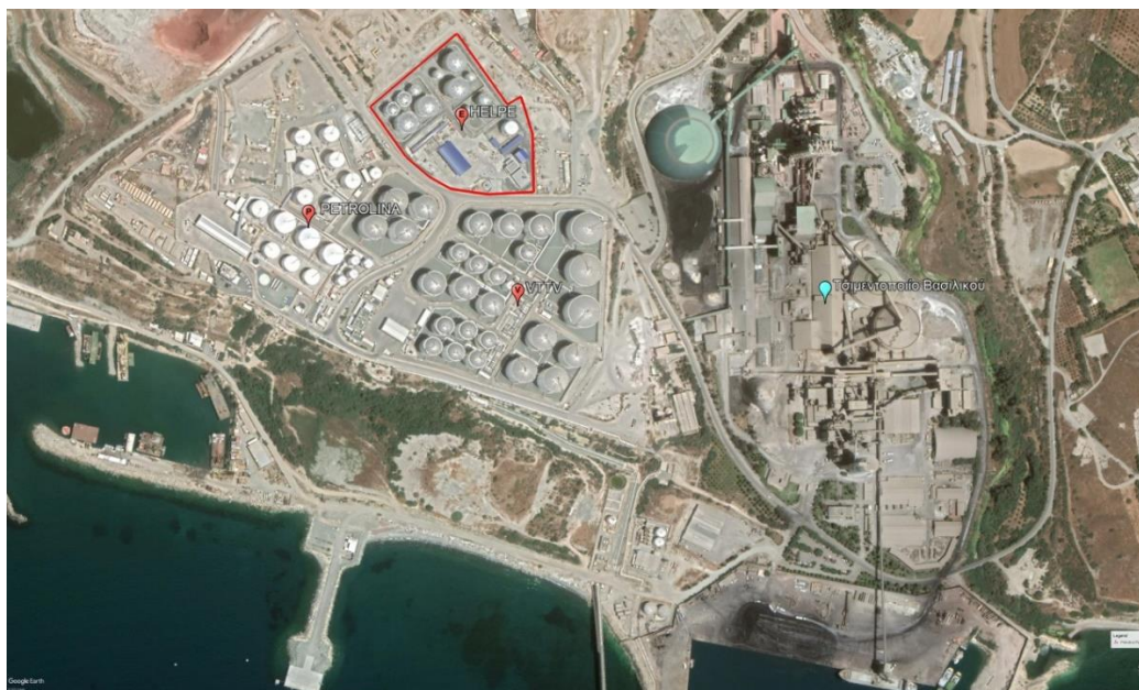
Εικόνα 4-10. Εγκαταστάσεις τερματικού αποθήκευσης υγρών καυσίμων Υγες (ΕΛΠΕ) στο Βασιλικό.
