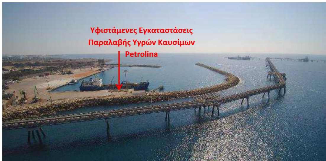
Εικόνα 6-6. Υφιστάμενες Εγκαταστάσεις Παραλαβής Υγρών Καυσίμων εντός λιμένα Βασιλικού.
