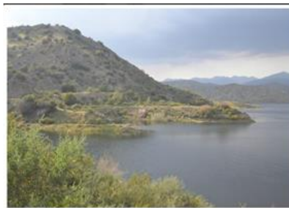
Εικόνα 3-9. Τεχνητή Λίμνη (φράγμα) Καλαβασού.
