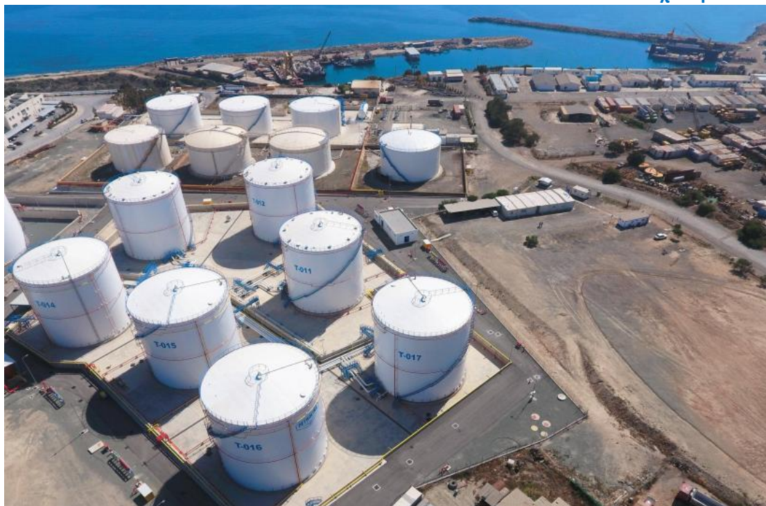
Εικόνα 4-6. Εγκαταστάσεις τερματικού αποθήκευσης και διακίνησης υγρών καυσίμων Petrolina στο Βασιλικό.
