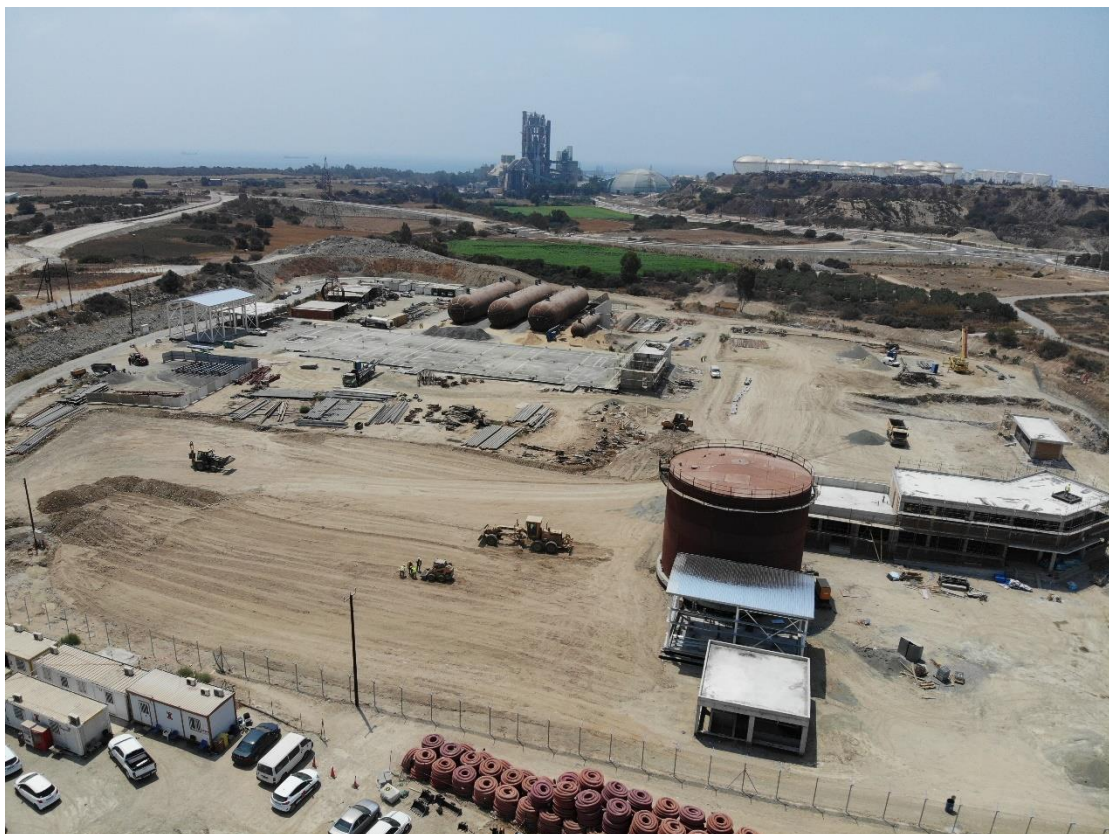
Εικόνα 6-5 Υφιστάμενες εργασίες του υλοποιούμενου έργου V LPG (φωτογραφία ημερομ. 23/07/21).
