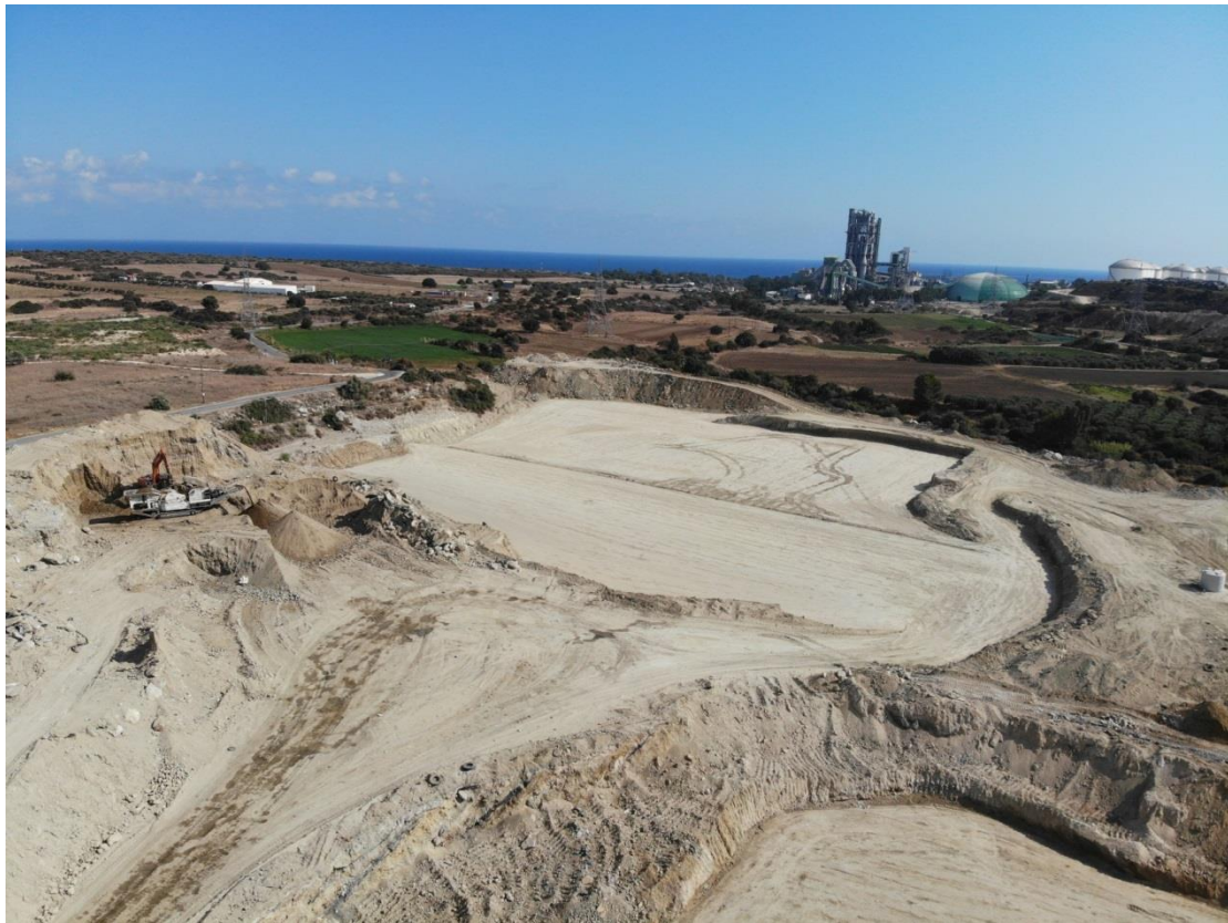
Εικόνα 6-3. Χωματουργικές Εργασίες στο βιομ. τεμ 35 (φωτογραφία ημερ. 16/09/19).
