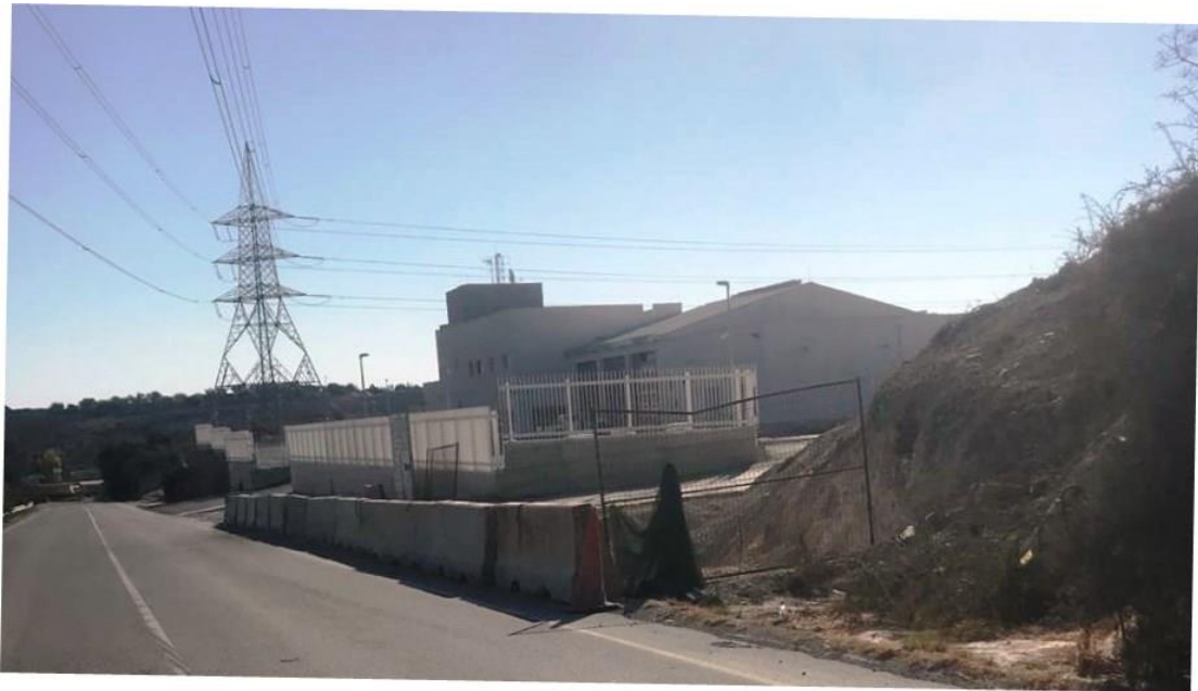
Εικόνα 7-1. Πυροσβεστικός Σταθμός Βασιλικού – Μαρί.
