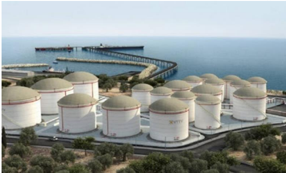
Εικόνα 4-11. Εγκαταστάσεις και Jetty της VVTV στο Βασιλικό.
