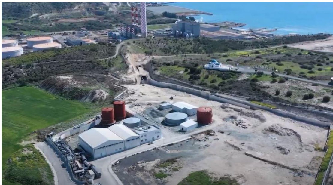
Εικόνα 4-3. Χώρος ανέγερσης των εγκαταστάσεων της εταιρείας PEC στο Βασιλικό.
