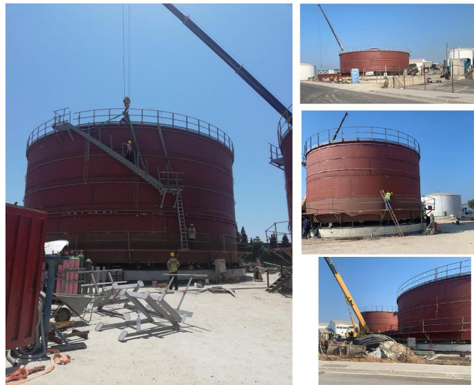
Εικόνα 6-11 Φωτογραφίες του υπό ανέγερση σταθμού ασφάλτου ημερομηνίας 30/06/21
