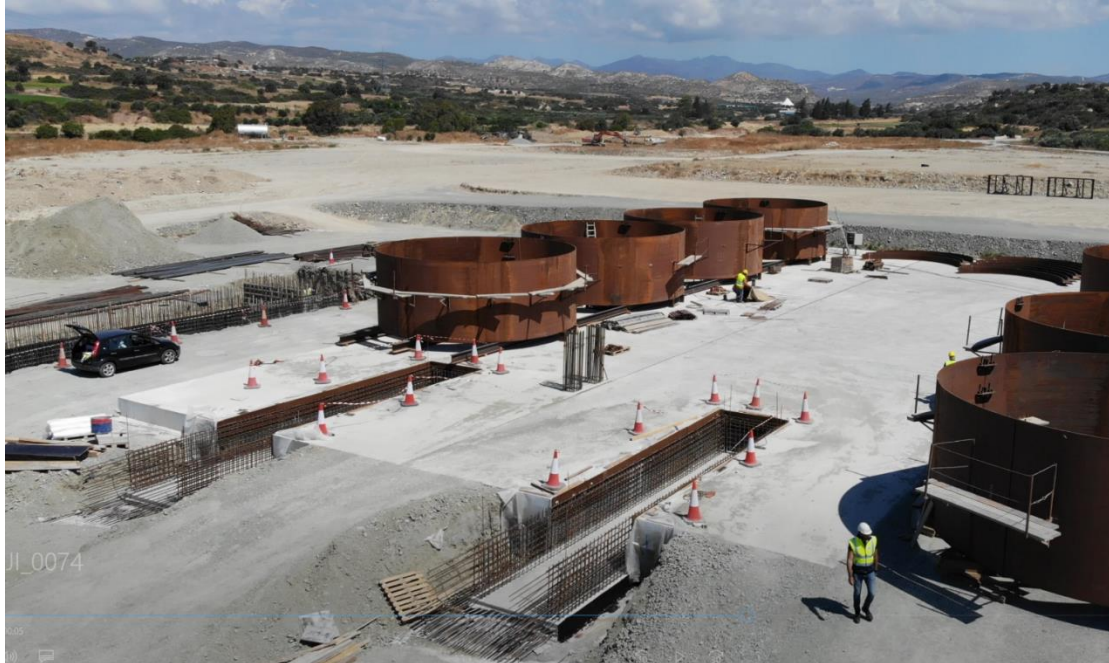
Εικόνα 6-4. Υφιστάμενες εργασίες του υλοποιούμενου έργου V LPG (φωτογραφία ημερ. 03/06/20).
