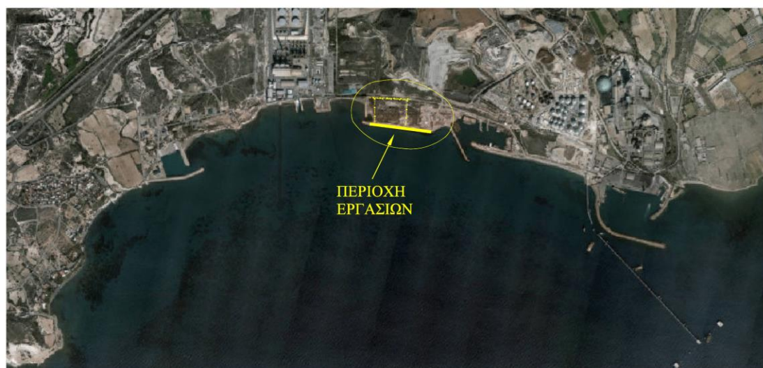
Εικόνα 4-21. Περιοχή χώρου απόθεσης Φωσφογύψου στην περιοχή των πρώην ελληνικών Χημικών Βιομηχανιών στο Βασιλικό και Κατασκευή Θωράκισης για προστασία από τη θαλάσσια διάβρωση του παραλιακού μετώπου.
