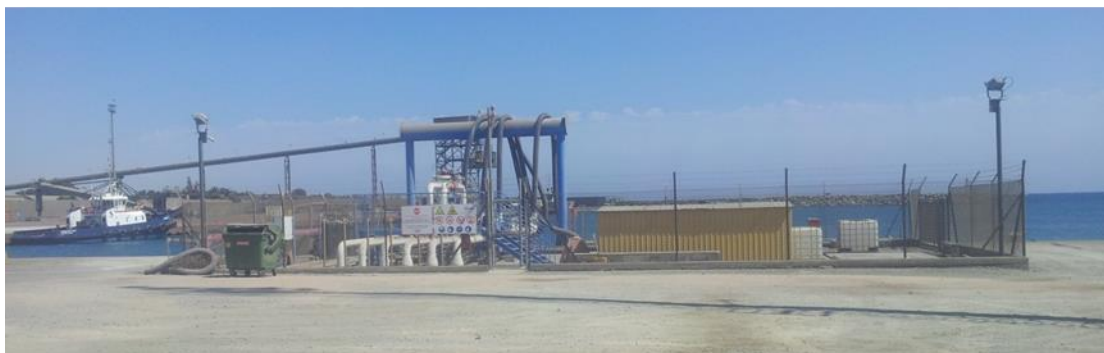
Εικόνα 6-7. Υφιστάμενες Εγκαταστάσεις Παραλαβής Υγρών Καυσίμων εντός λιμένα Βασιλικού.
