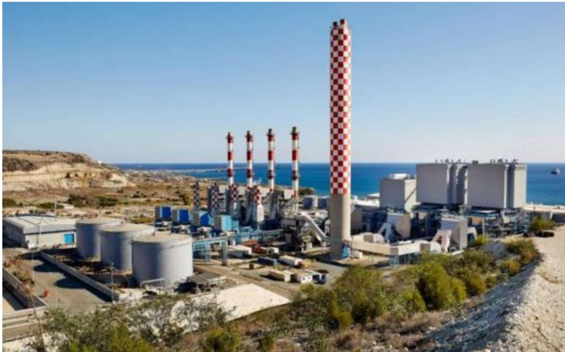
Εικόνα 3.2: Εγκαταστάσεις και μονάδες ηλεκτροπαραγωγικού σταθμού της ΑΗΚ
